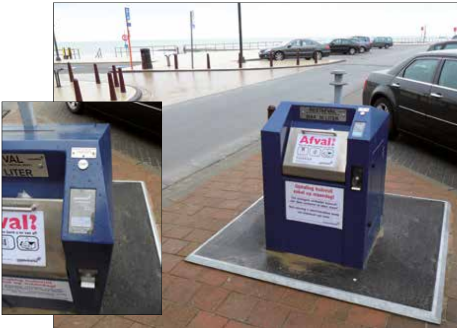
Controlo de acesso com pagamento com moedas num contentor enterrado (Middelkerke, Bélgica).
