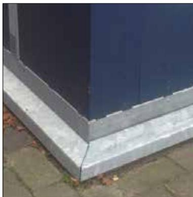
**O espaço entre a superfície do solo e o contentor está selado por uma placa, para evitar infiltração de areia ou folhas.**
